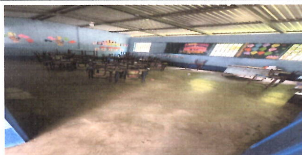
FOTO5: PISO Sustitución de piso de concreto con acabado liso por piso cerámico, incluyendo preparación de superficie y nivelación.
