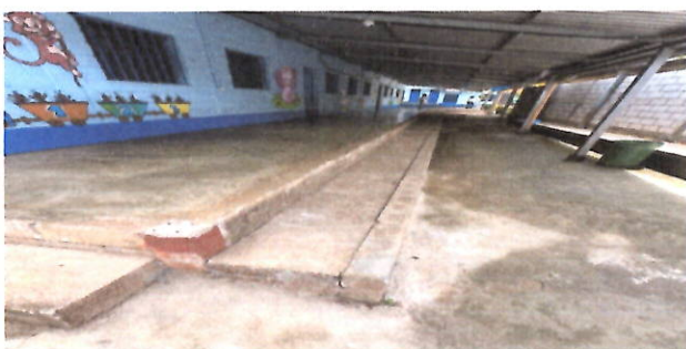
FOTO3: PISO Sustitución de piso de concreto con acabado liso por piso cerámico, incluyendo preparación de superficie y nivelación.
