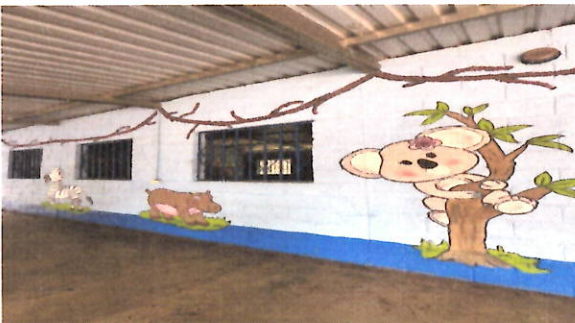
FOTO4: VENTANAS Sustitución de ventanas: sistema de apertura: Corredizas, Perfiles color blanco estándar, Material del marco: PVC Material de la ventana: Vidrio, sellado perimetral.
