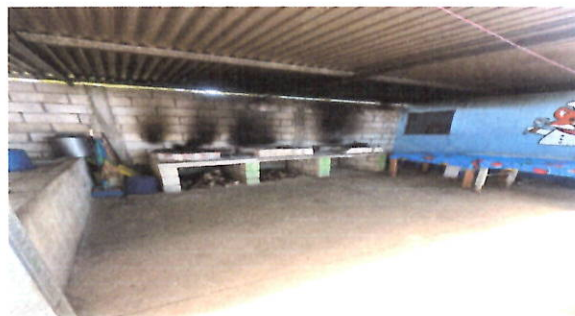
FOTO2: PISO Sustitución de piso de concreto con acabado liso por piso cerámicos antideslizante, incluyendo preparación de superficie y nivelación. En área de cocina
