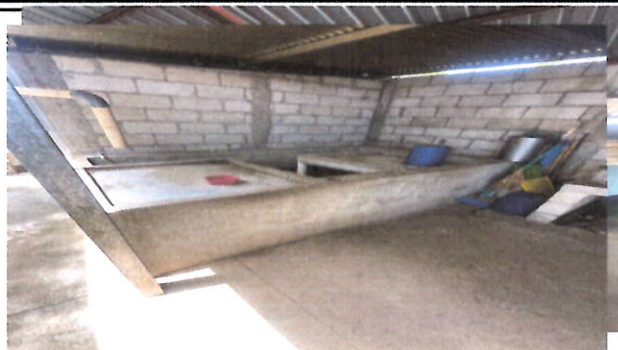
FOTO1: REPARACIÓN O SUSTITUCIÓN DE AZULEJO Sustitución de piso Tipo: azulejo, trabajo de nivelación, instalación alineada y sizado en juntas. En pila de cocina
